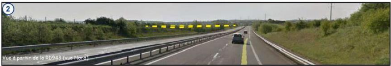
Perception depuis la RD942 vers le site
